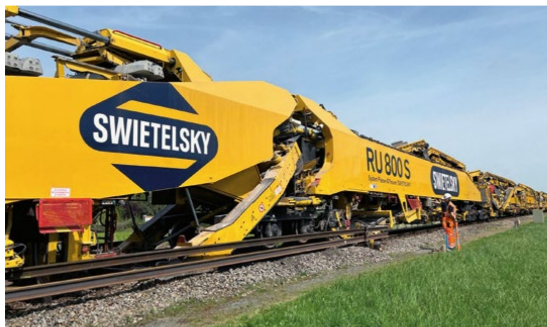
Kompletní rekonstrukce trati Mannheim–Frankfurt am Main, Německo
