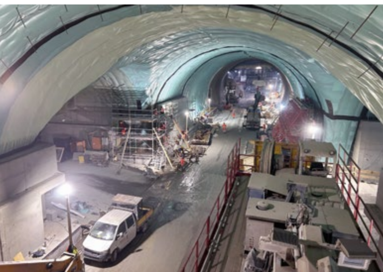
Úpatní tunel Semmering, Steinhaus am Semmering, Rakousko
