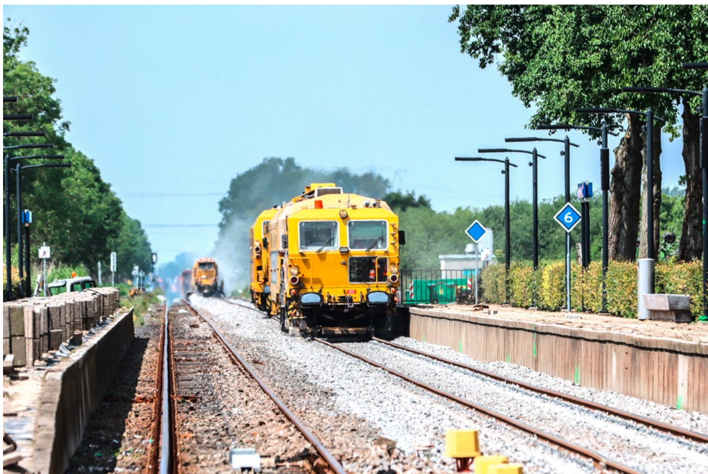
Trať, Tiel-Elst, Nizozemsko
