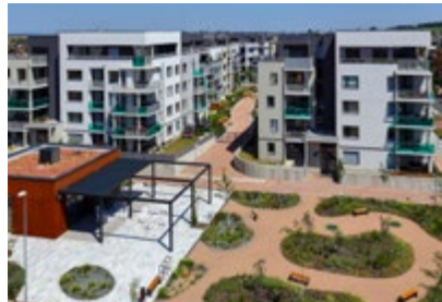
Bytový komplex Dolní Chabry, Česká republika
