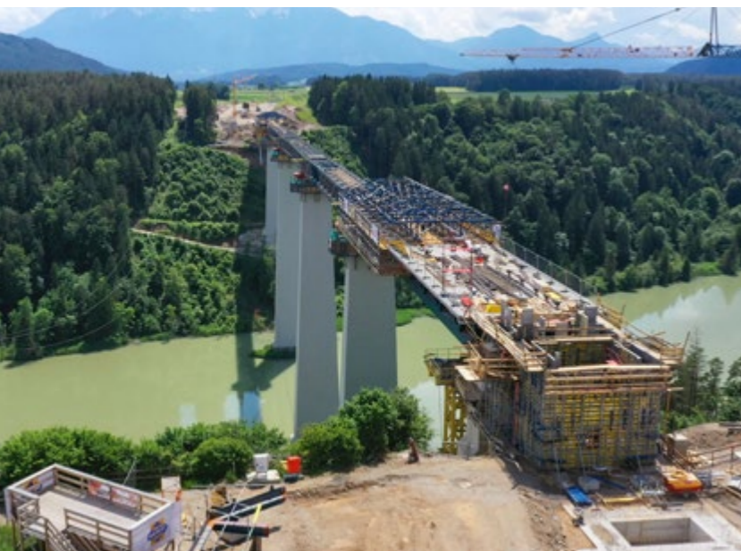
Jauntalbrücke, Ruden, Rakousko
