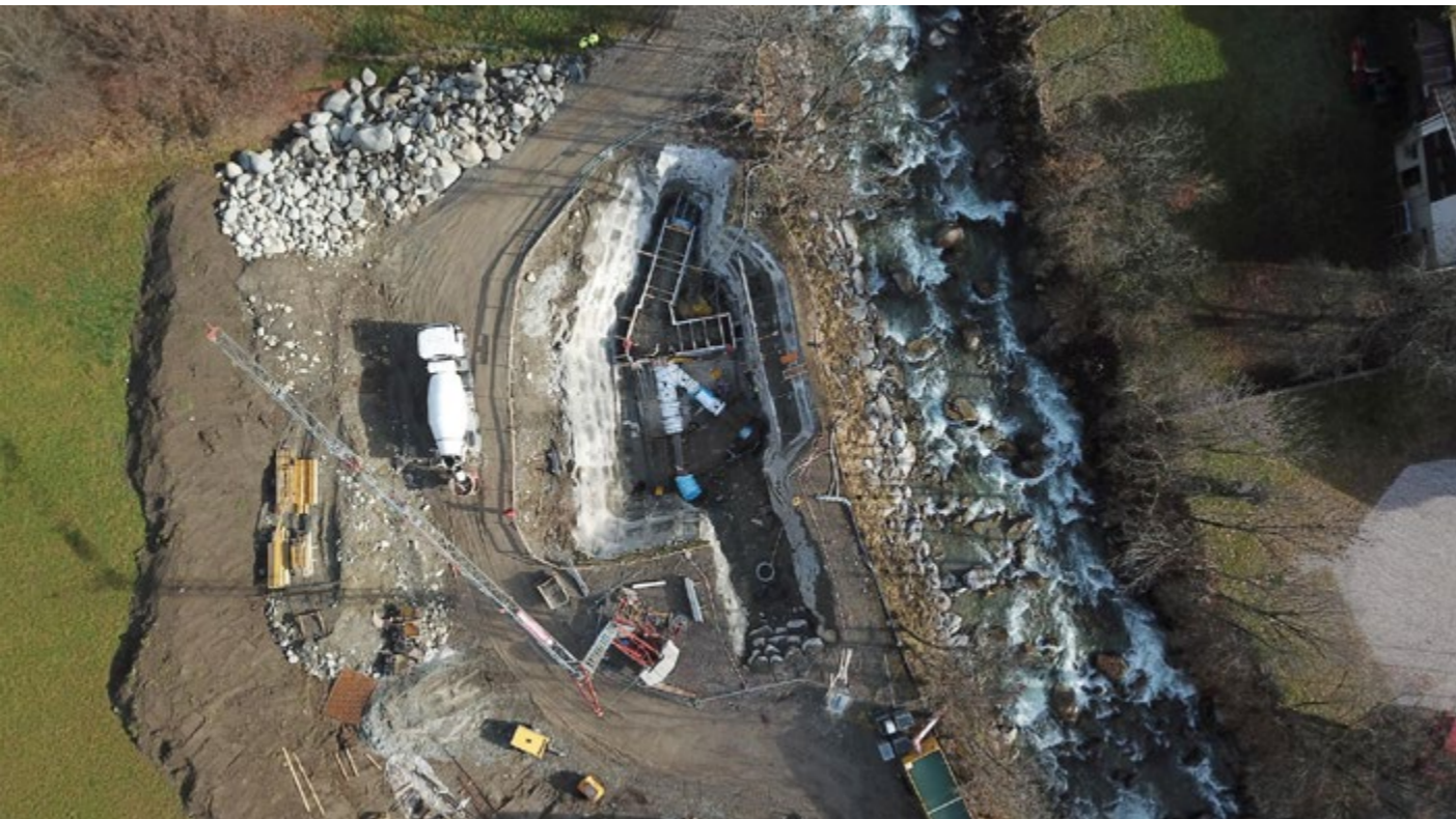
Zemní práce, Vereinigungsbauwerk KW Sellrain, Rakousko
