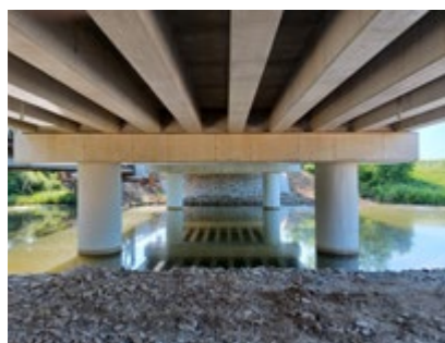
Rekonstrukce mostu Stretava, Slovensko
