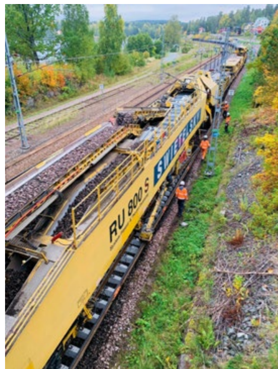
Obnova trati "Ängelsberg-Snyten", Švédsko
