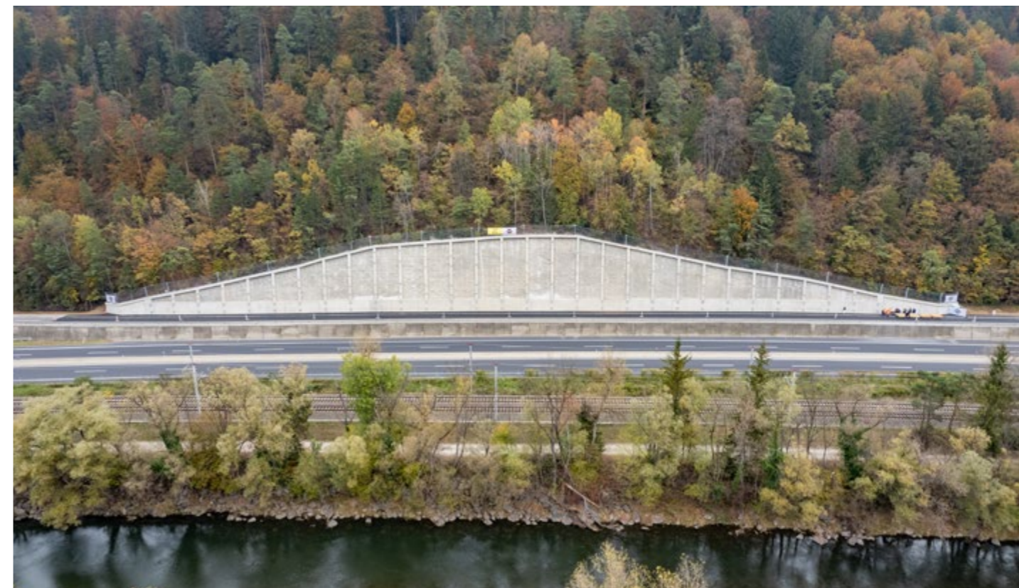
Sanace "Zdi nárků", Frohnleiten, Rakousko
