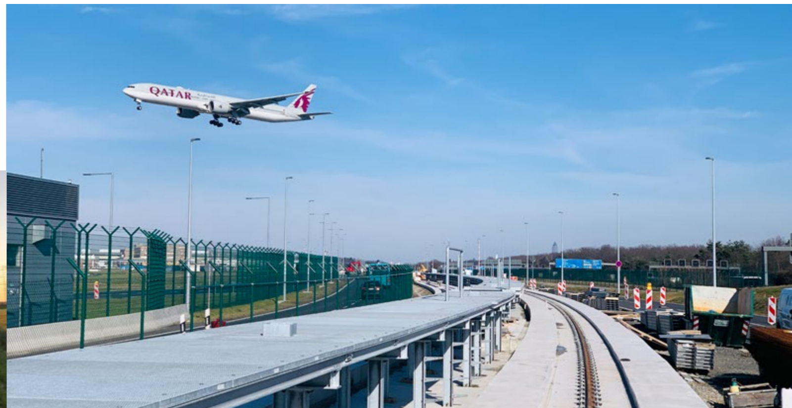
Montáž kolejnic a přípojníc, PTS FRA, Frankfurt, Německo
