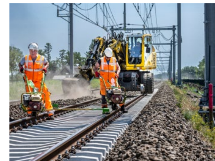
Sanace tratě Culemborg, Nizozemsko
