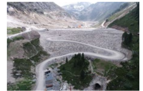
Budování hráze elektrárny Kühltal, Rakousko
