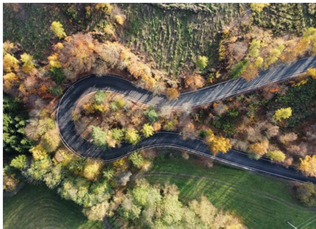
Silnice III/37367, úsek Křtiny-Březina, Česká republika
